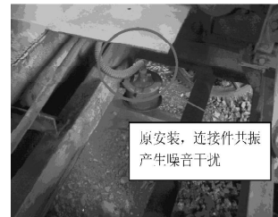
图2 选矿竖炉矿仓虚假回波
